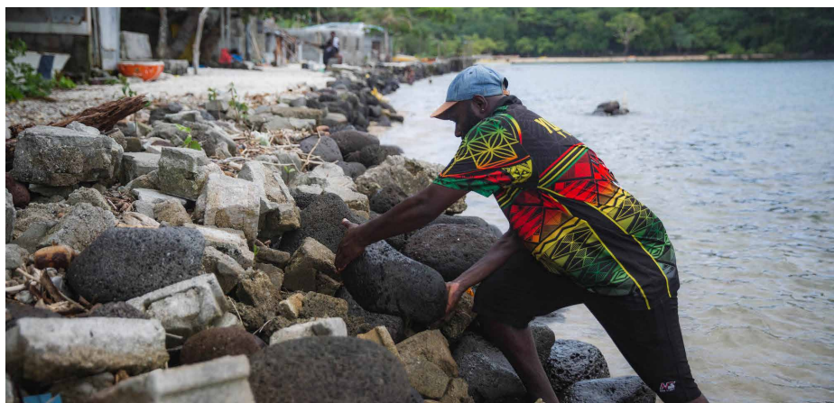
瓦努阿图埃毛岛（Emao Island）为减缓海岸侵蚀而修建的海堤。化石燃料排放的温室气体导致海平面上升，威胁着瓦努阿图等太平洋低洼岛国的生存。图片来源：© Niki Kuautonga / Greenpeace
